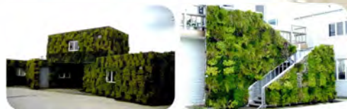
▲우리꽃 이천분사의 정원 리모델링의 하나로 시공된 컨테이너 수직정원(좌)과 케단수직정원(우)
